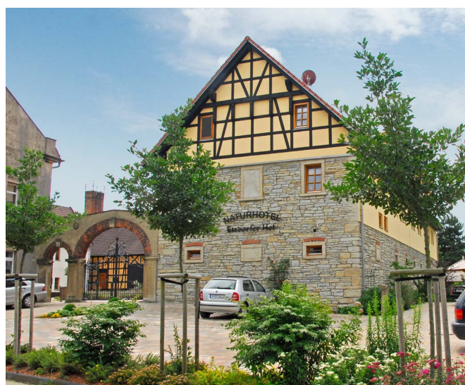
Früher Kuhstall, jetzt „Naturhotel Etzdorfer Hof“. Der obere Teil des Gebäudes wurde abgerissen und neu gebaut, das historische Gewölbe erhalten und von einheimischen Handwerkern saniert.
